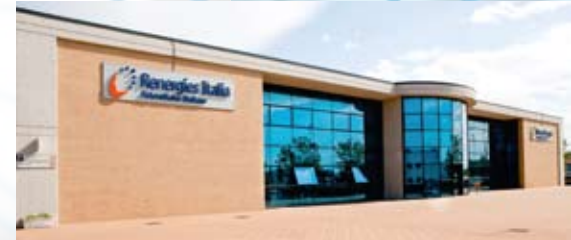
La sede principale di Renergies Italia
